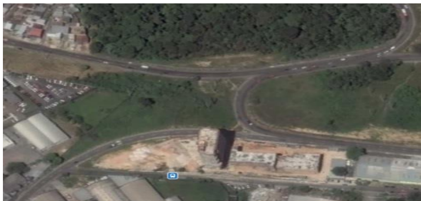
Figura 1 - Locação da obra 1
